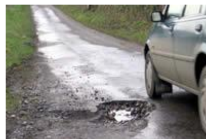
Asfalto duobių remontas
