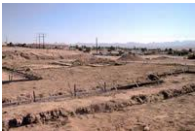
Statybinės aikštelės dulkių kontrolė, purvo panaikinimas
