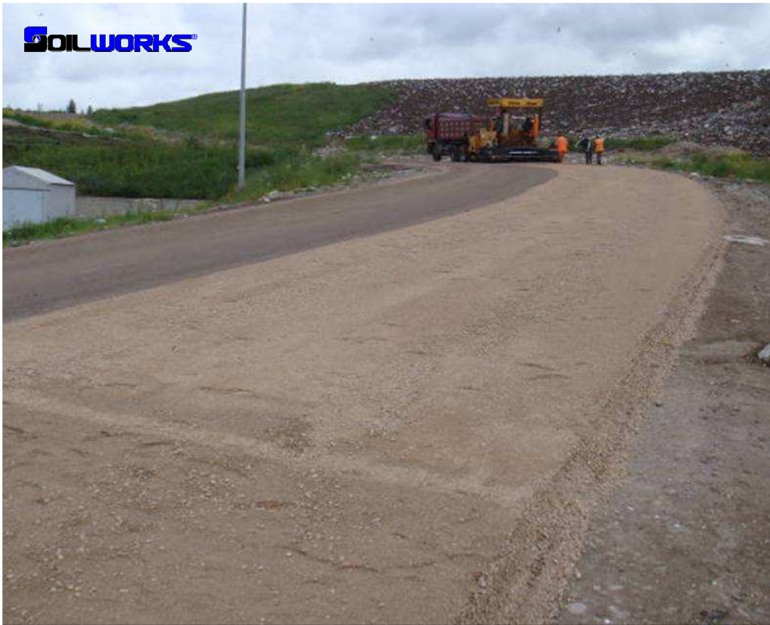
Укладка грунта для смешения велась асфальтоукладчиком слоем 15 см. Грунт – песок и гравий порядка 0,15, бросовый грунт из заброшенного карьера. Использовать грунт с самой свалки было невозможно по понятным причинам.
