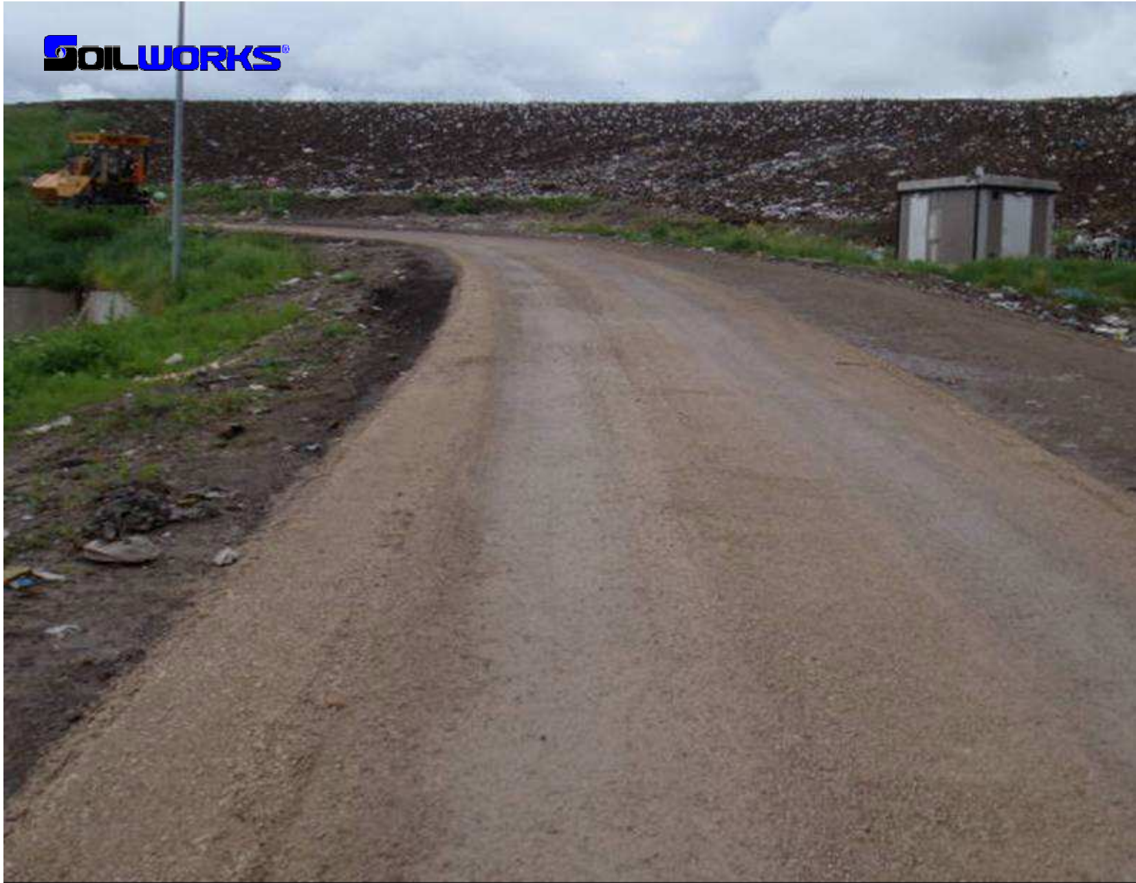
Первая полоса движения дороги после уплотнения
