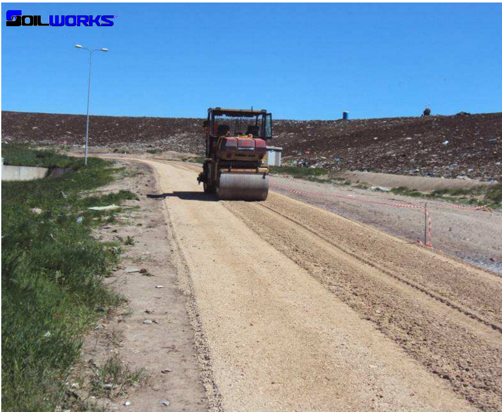
Начало уплотнения грунта после смешения. Уплотнение производится сразу после смешения. Обеспечить уплотнение не менее 95% максимальной плотности.
