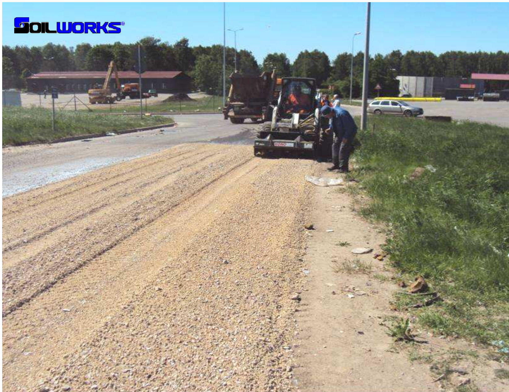
Заключительное смешение культиватором после достижения грунтом оптимальной влажности.
