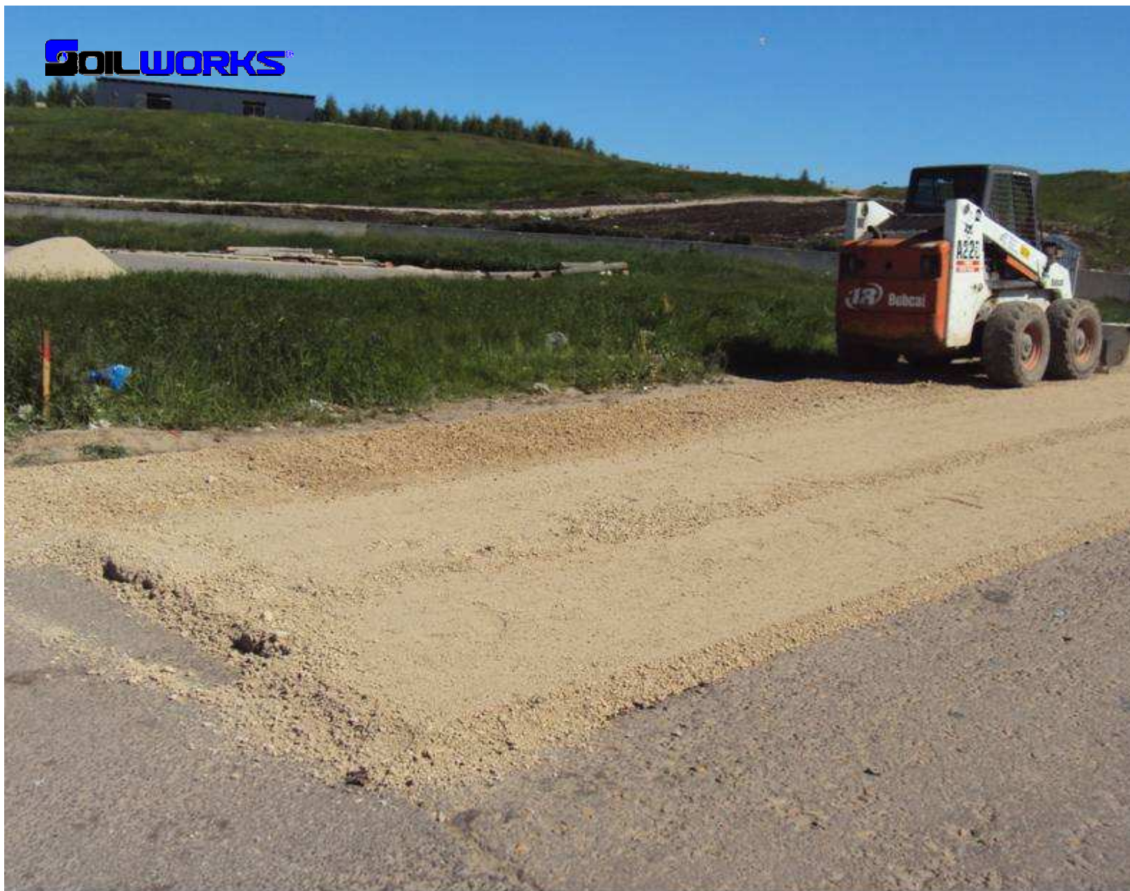
Смешение грунта после первого полива БобКатом с навесной фрезой. (На снимке начало работ с места окончания асфальтного покрытия старой дороги.)
